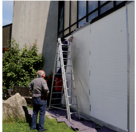
Vorbereitende Arbeiten: Abdeckung der Kirchenwand; Vielen Dank an die Helfer!
